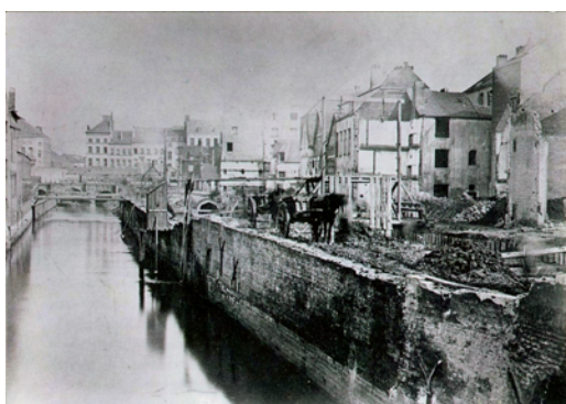
Figure 1.9 : les travaux du voûtement de la Senne, source IRPA-KIK Bruxelles in (Deligne, 2005)
