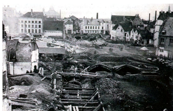
Figure 1.9 : les travaux du voûtement de la Senne, source IRPA-KIK Bruxelles in (Deligne, 2005)
