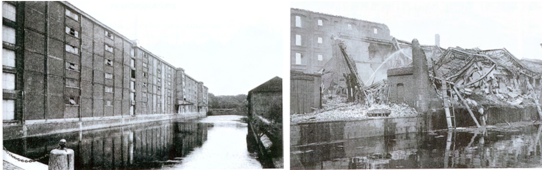
Figure 1.13: Le port Vauban et la destruction de ses magasins généraux en 1963 (Caniot, 2005)
