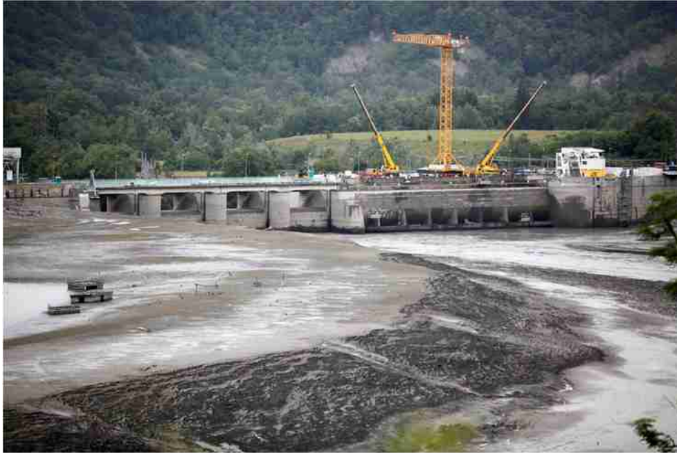
FIGURE 1.2 – Vidange de la retenue de Verbois lors de la chasse du Rhône de 2012 (source inconnue)
