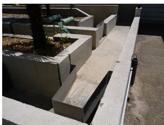
(c) Détail du déversoir en bec de canard
