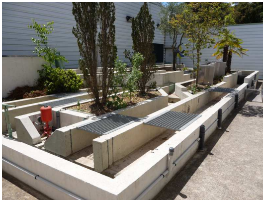
(a) Vue générale du grand canal de l'ENSAM
