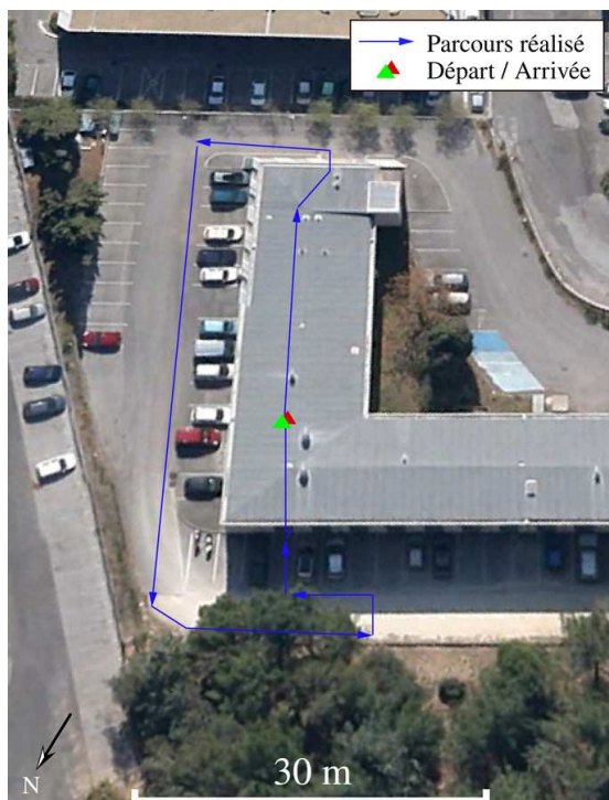
FIGURE 5.10 – Vue aérienne du bâtiment de la Maison des Sciences de l’Eau et représentation schématique du parcours réalisé à l’air. Les flèches bleues indiquent la direction et l’orientation principale du déplacement, les triangles vert et rouge indiquent le point de départ et d’arrivée du parcours. La figure montre que le parcours est à l’intérieur et à l’extérieur du bâtiment. Deux directions principales de déplacement peuvent être identifiées. Vue aérienne : DigitalGlobe.
