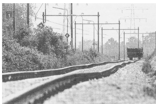
FIGURE 1.7 – Dégradation géométrique de la voie [125].
