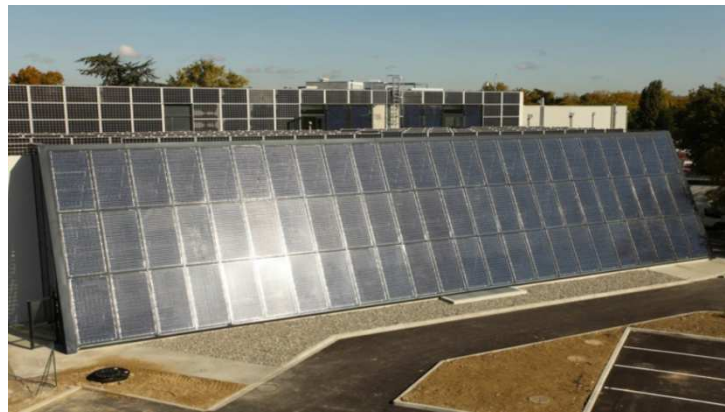
Figure II- 4: Bâtiment ADREAM, LAAS-CNRS, Toulouse
