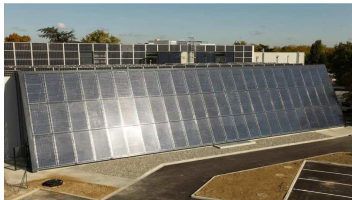
Figure II- 4: Bâtiment ADREAM, LAAS-CNRS, Toulouse
