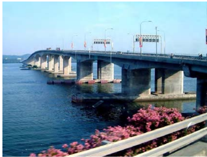
Figure I.3 : Le « Malaysia-Singapore second link » reliant Singapour à Johor (Malaisie) inauguré en 1998.
