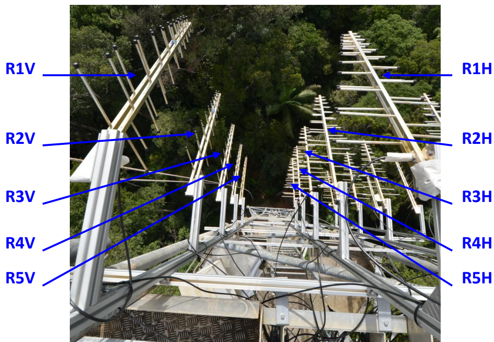
Figure 51. Montage sur la tour des antennes correspondant à la réception des polarisations V et H.
