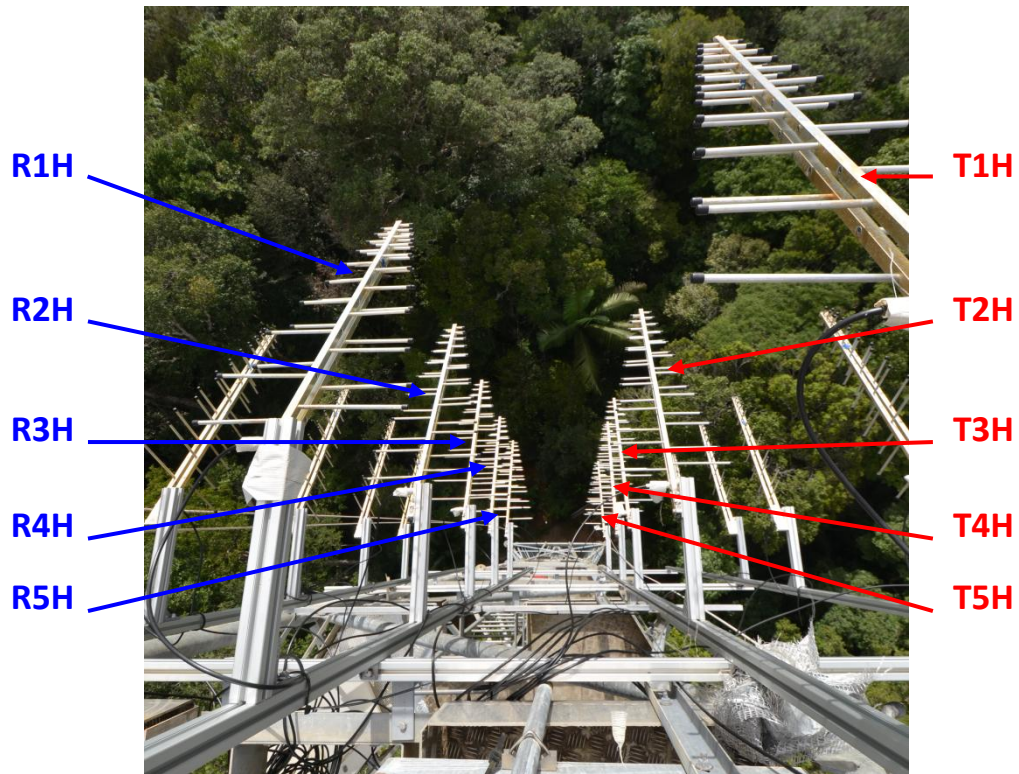
Figure 50. Montage sur la tour des antennes correspondant à la réception en H et à la transmission en V.
