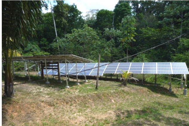
Figure 17. TropiScat : Panneaux solaires alimentant en électricité le camp et les appareils scientifiques.
