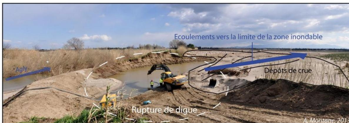
Photographie 13 : Rupture de la digue de l'Agly, sur la commune de Pia en mars 2013
