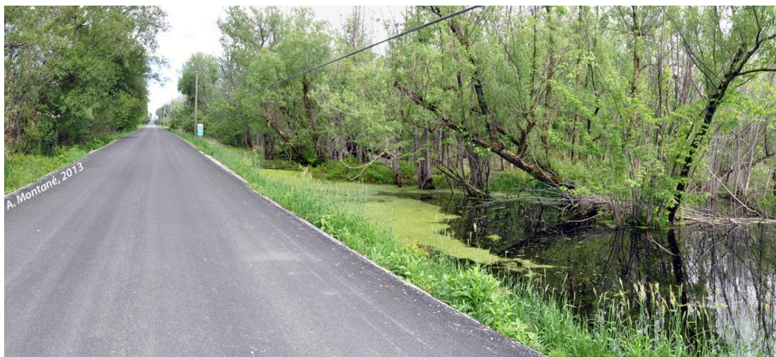
Photographie 10: Route remblayée en zone inondable qui relie des habitations à la route principale
