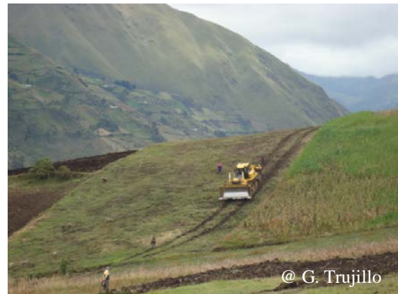
Figure 24. La cangahua , dépôt de cendre indurée en surface et réhabilitation de celle-ci au moyen de bulldozer.
