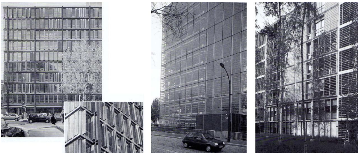
Figure 27 : Exemple de brise-soleil. Source : MONNIER, Gérard. L'architecture moderne en France : tome 3, de la croissance à la compétition 1967-1999 . Paris : Picard, 2000, 311 p.
