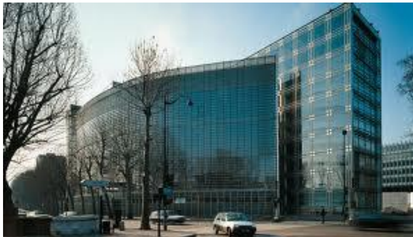
Figure 74 : Façade nord de l'IMA
