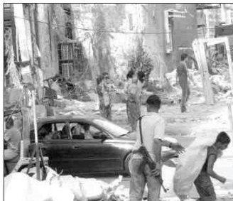
Spéculer de démolition, hier matin, dans la banlieue sud après les bombardements de la nuit.
