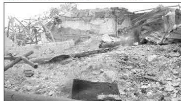
Les dégâts à Médeïr.
