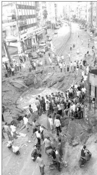
Le cratère causé par une bombe israélienne au milieu de cet important axe routier.
