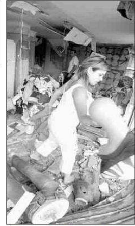
Il ne reste rien de ce magasin totalement dévasté par le souffle de l'explosion d'une bombe israélienne.
