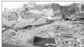
Les dégâts à Médeïr.
