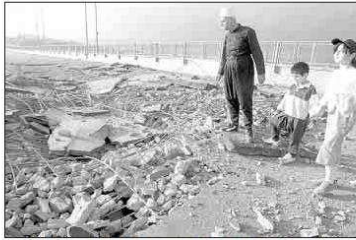
Un notable duze inspectant les dégâts causés à l'autoroute de Solar, bombardée hier, à l'aube.
