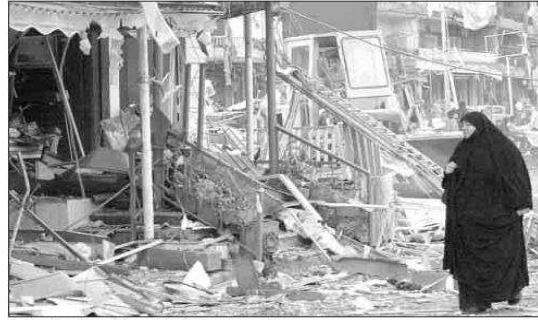
Une femme inspectant les dégâts causés à un établissement commercial.
