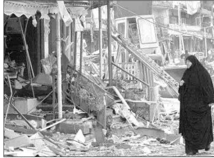
Une femme inspectant les dégâts causés à un établissement commercial.
