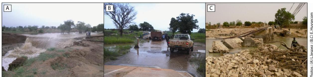
**Figure 2.9** : La crue du Yamé en 2007. (A) et (B) Routes coupées par les affluents du Yamé ; (C) Destruction des ponts à Bandiagara.
