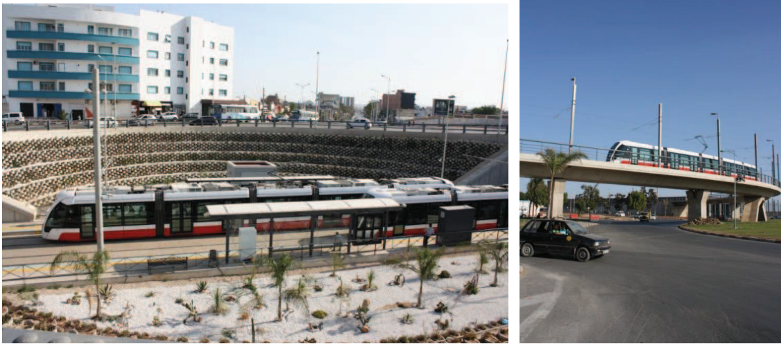
Figure 61 : Tramway descend dans une trémie et monte sur un viaduc au niveau des giratoires, photos : F. Kettaf (juin 2013)
