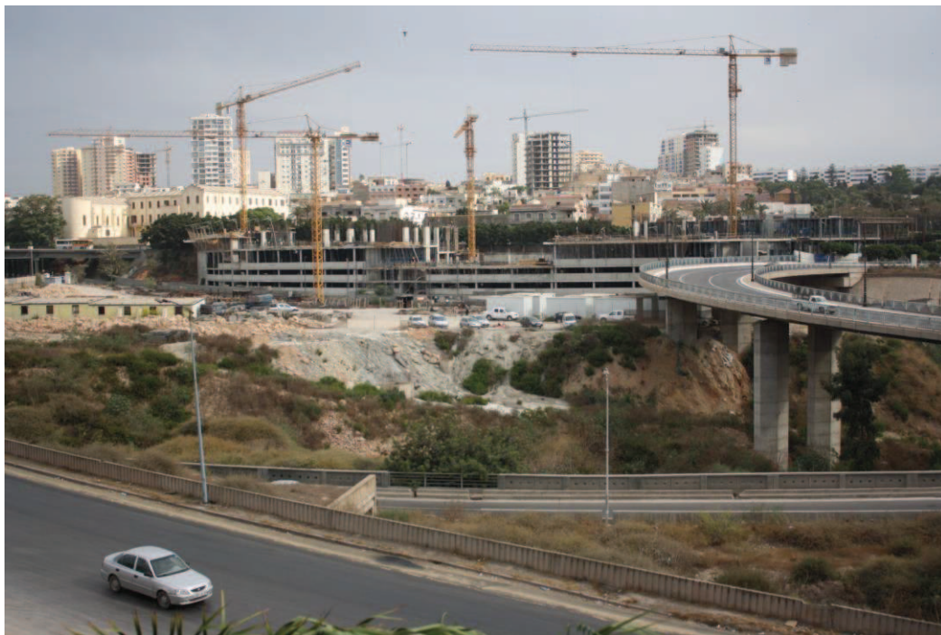
Figure 46: Construction de deux tours d'habitation par un promoteur privé occupant une servitude routière (désignée par le PDAU non constructible). Photo : F. Kettaf (septembre 2013)
