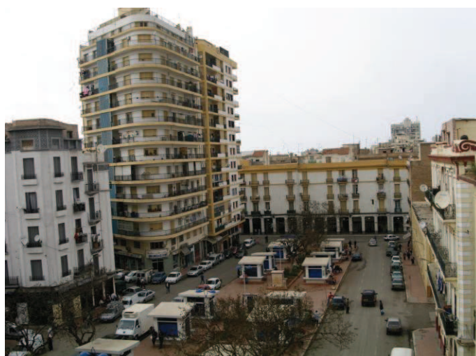
B) Place réaménagée pour installer des kiosques à fleurs en 2005
