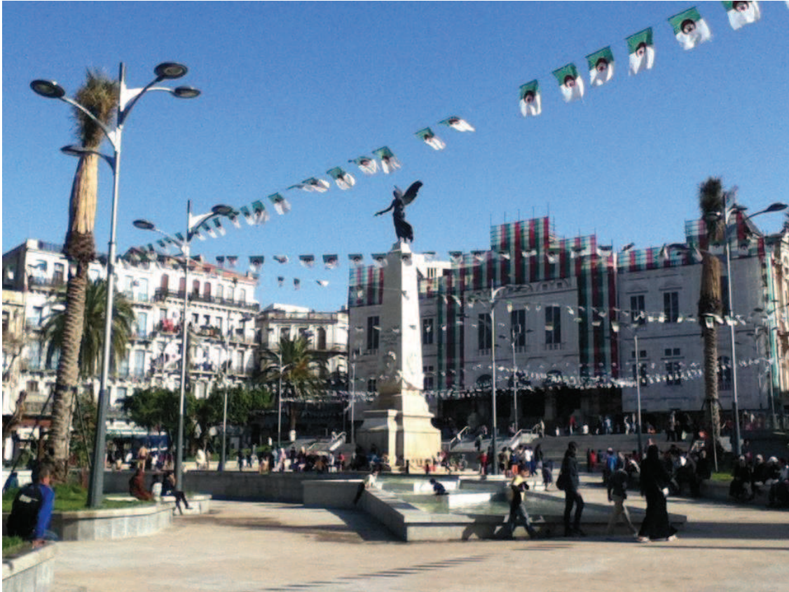
Figure 62 : Place 1 er Novembre 1954 réaménagé et Hôtel de ville en cours de réhabilitation, photo : F. Kettaf (1 er mai 2013)
