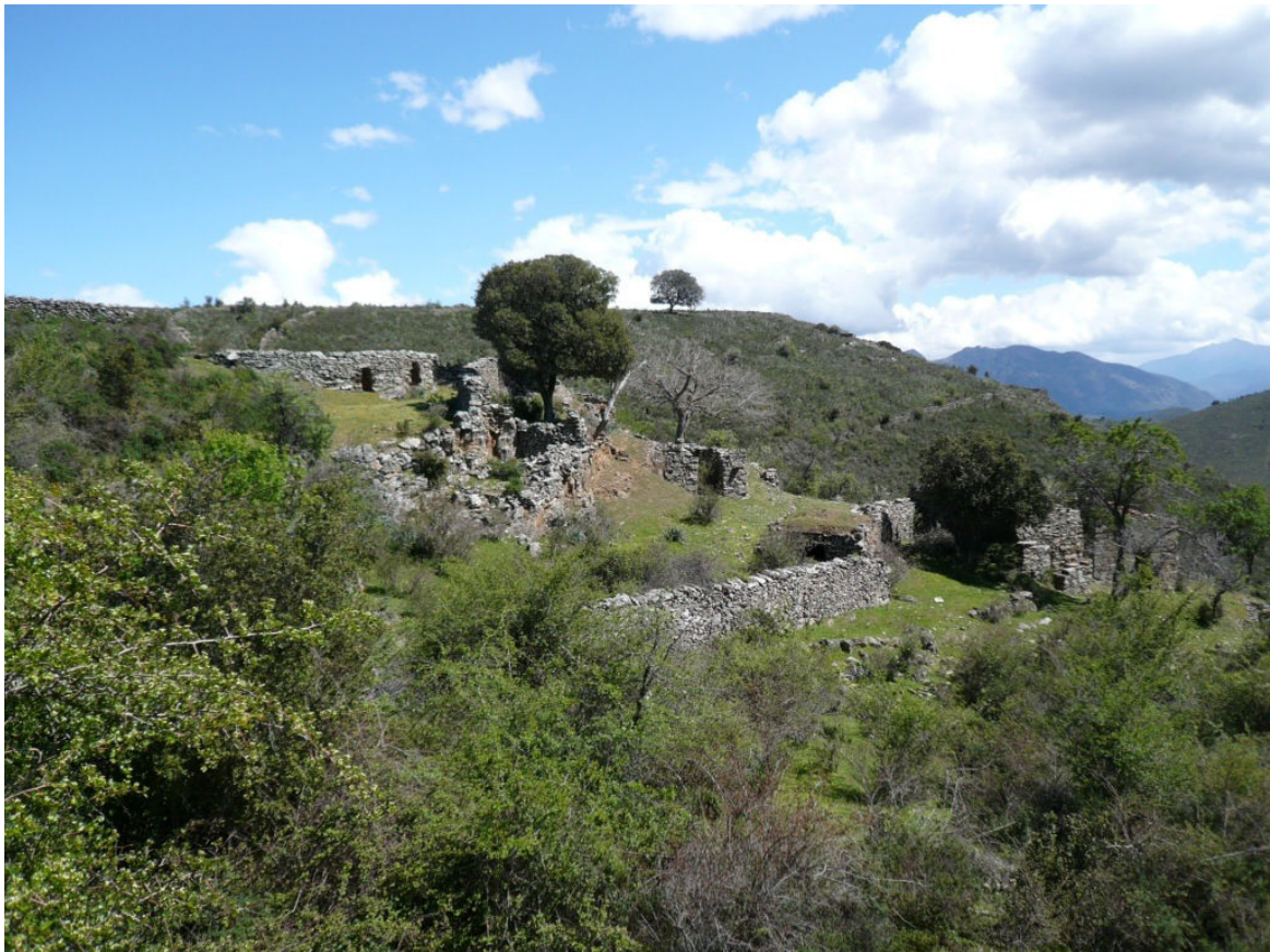
Figure 8 : murettes de soutien des terrasses (en pierre) ( mur , murettu... )/Nuvella
