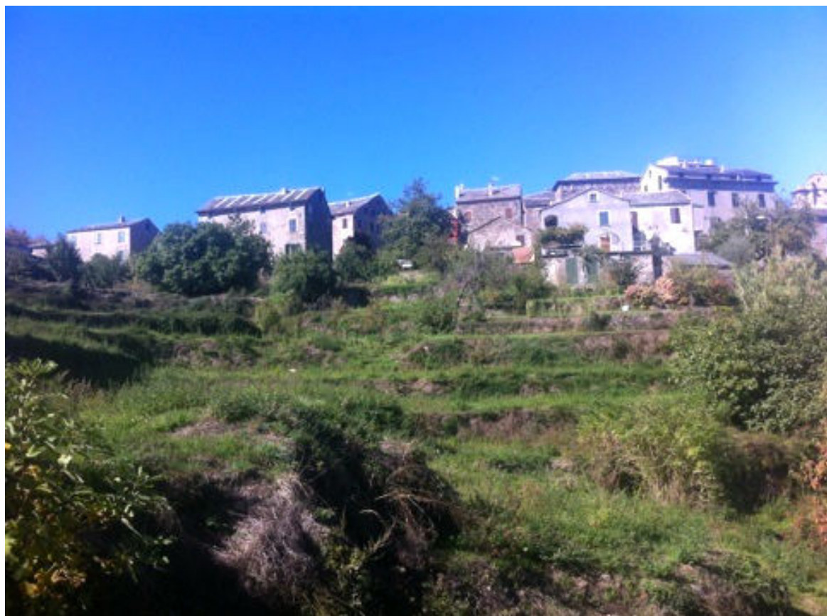
Figure 9 : murettes de soutien des terrasses (en terre) ( ripe... )/L'Oretu di Casinca
