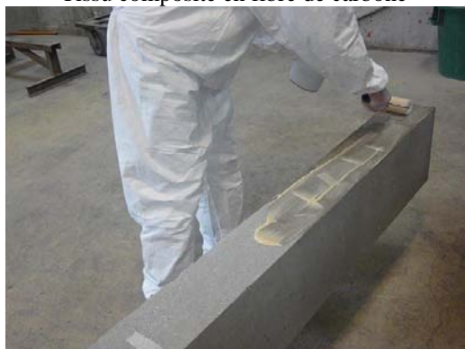
Première couche de la résine appliquée sur la surface tendue de la poutre
