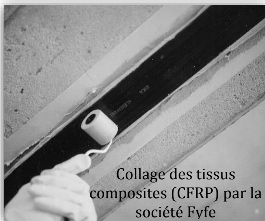
Figure I-7 : Installation de renforcement par collage des matériaux composites (FRP) sur la surface extérieure.
