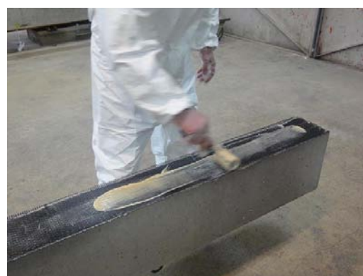
Deuxième couche de la résine sur le tissu composite (1 à 2 mm)
