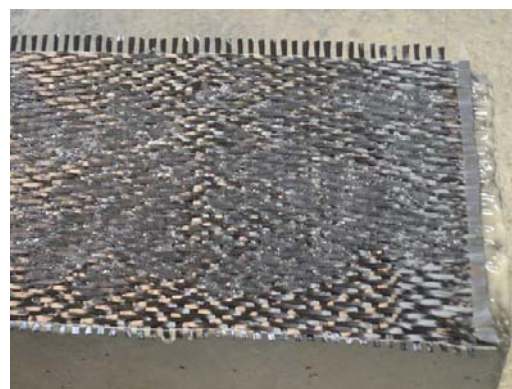
Mise en place manuellement le tissu composite
