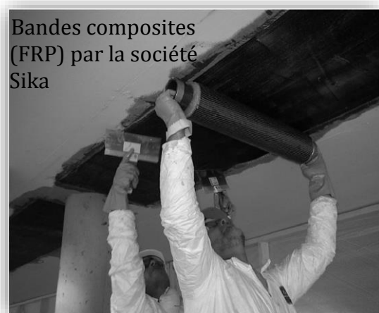
Figure I-7 : Installation de renforcement par collage des matériaux composites (FRP) sur la surface extérieure.
