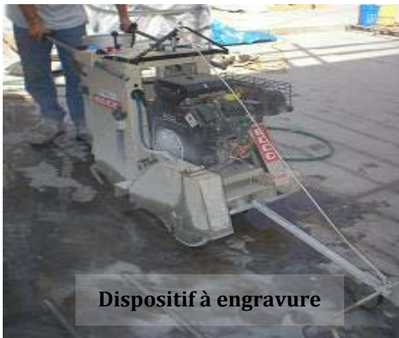
Figure I-9 : Applications de la technique NSM avec des barres composites (FRP).
