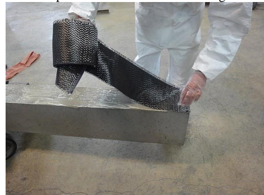
Mise en place manuellement le tissu composite
