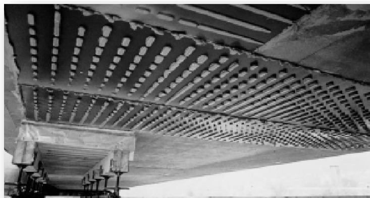
Renforcement d'un viaduc par tôles collées
