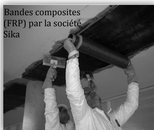
Figure I-7 : Installation de renforcement par collage des matériaux composites (FRP) sur la surface extérieure.
