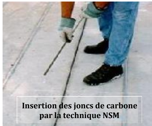
Figure I-9 : Applications de la technique NSM avec des barres composites (FRP).
