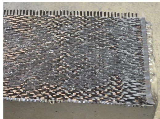
Mise en place manuellement le tissu composite
