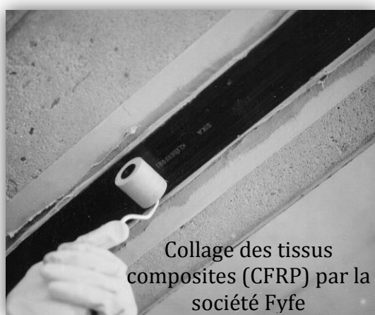
Figure I-7 : Installation de renforcement par collage des matériaux composites (FRP) sur la surface extérieure.
