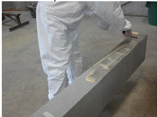
Première couche de la résine appliquée sur la surface tendue de la poutre
