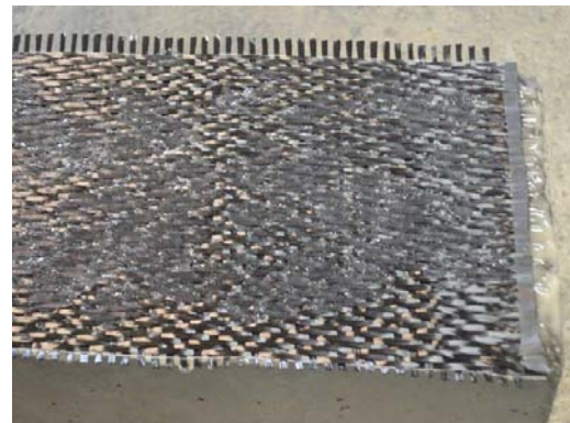
Mise en place manuellement le tissu composite
