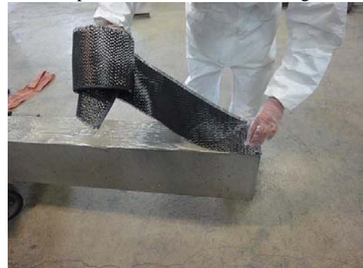
Mise en place manuellement le tissu composite
