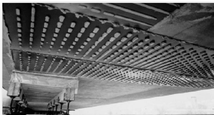
Renforcement d'un viaduc par tôles collées
