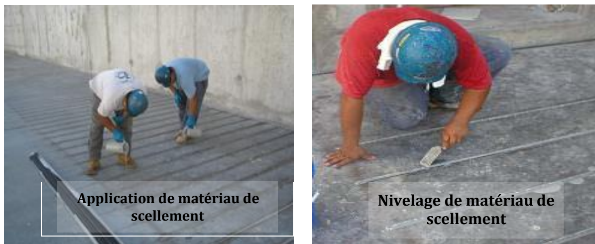
Figure I-10 : Procédures du renforcement d'un nouveau réservoir d'eau en utilisant de la technique NSM avec des joncs en fibre de carbone CFRP (SPS Structural Preservation Systems s. d.).
