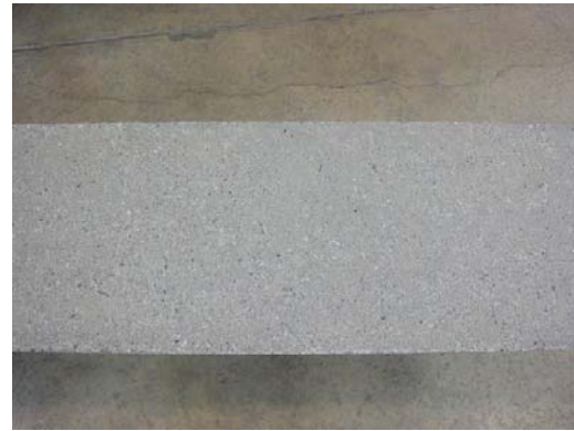
Préparation de la surface du collage
