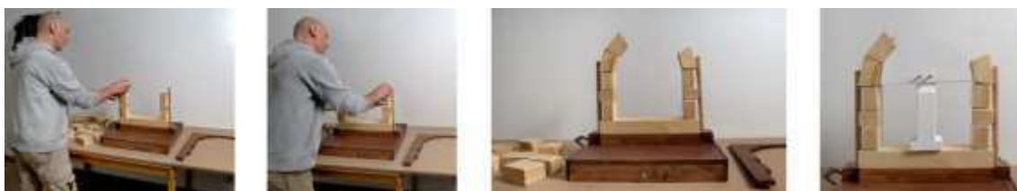
Illustration 14 : « Notice de montage » d'un encadrement de fenêtre
