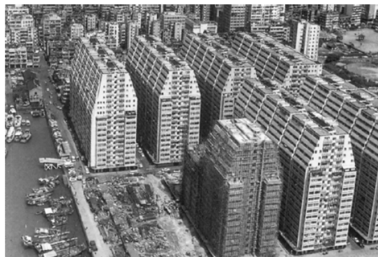
FIGURE 1.7: Quartier de très haute densité à Hong-Kong. L'angle au sommet des immeubles permet de respecter l'obstruction maximale de 71,5^\circ demandée par la réglementation de Hong-Kong. Source : (Ng, 2012)
