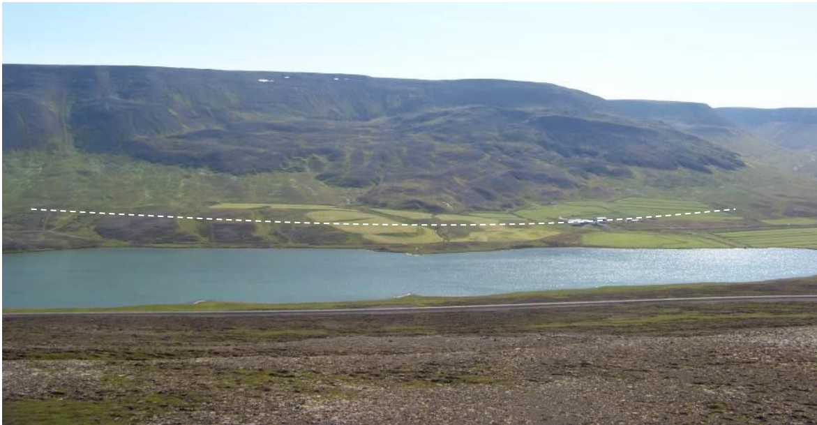
Figure 30 : Dépôt de glissement de terrain décollé du fond de vallée (Skagafjordur, Islande).
