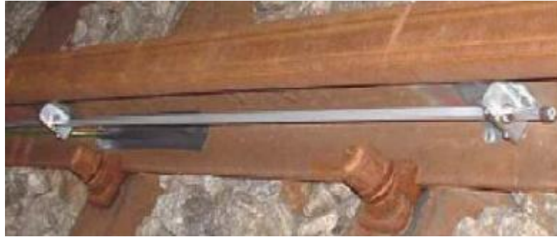
Figure 8 : a. Principe d'un capteur interférométrique de type Michelson. b. Application d'un capteur SOFO sur une poutre en acier (Images extraites de Cumunel, 2008).
