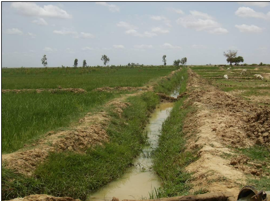
Photo 6a. Une vue du canal principal d'irrigation
