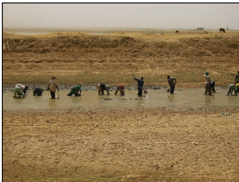
Photo 34. Désensablement du lit du fleuve Niger pour le pompage de l'eau en avril 2008 : PPIV de Dientakaye 2
