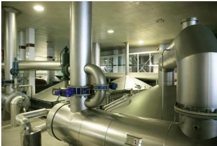
Figure 2 : Configuration type ou "idéale", selon le PAT, d'une instrumentation optique (en bleu) *in-line* implantée sur une ligne de production (pharmaceutique dans cet exemple) - image INDATECH
