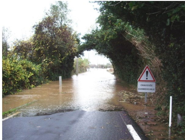
FIGURE 1.3 – Route submergée dans le département de l’Hérault. Source : Conseil Général de l’Hérault
