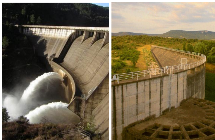
FIGURE 2.9 – Barrage de Sénéchas sur la Cèze (gauche) et de Ceyrac sur le Rieumassel, affluent du Vidourle (droite). Source : CG30.
