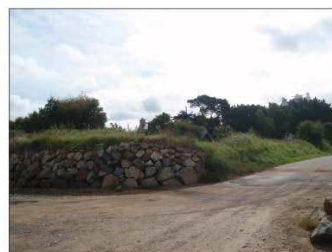
Photo n°2 : Vue au nord-ouest de la parcelle
