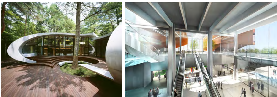
Figure 80 : L'architecture contemporaine favorise la continuité des espaces : Shell villa, Japon, Nagano architecture (à gauche), projet du nouveau Centre des Congrès de Nancy, Atelier Barani (à droite).
