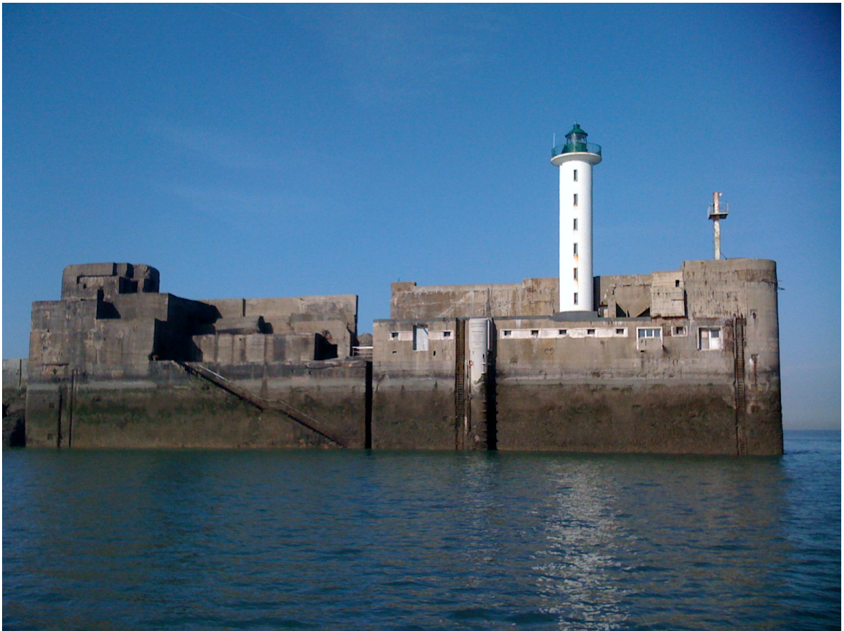
Figure 1-3. Station MAREL Carnot installée sur la digue Carnot à la sortie de la rade du port de Boulogne-sur-Mer : la station est le tube situé à gauche du phare sur la photo. (Photographie F. G. Schmitt)
