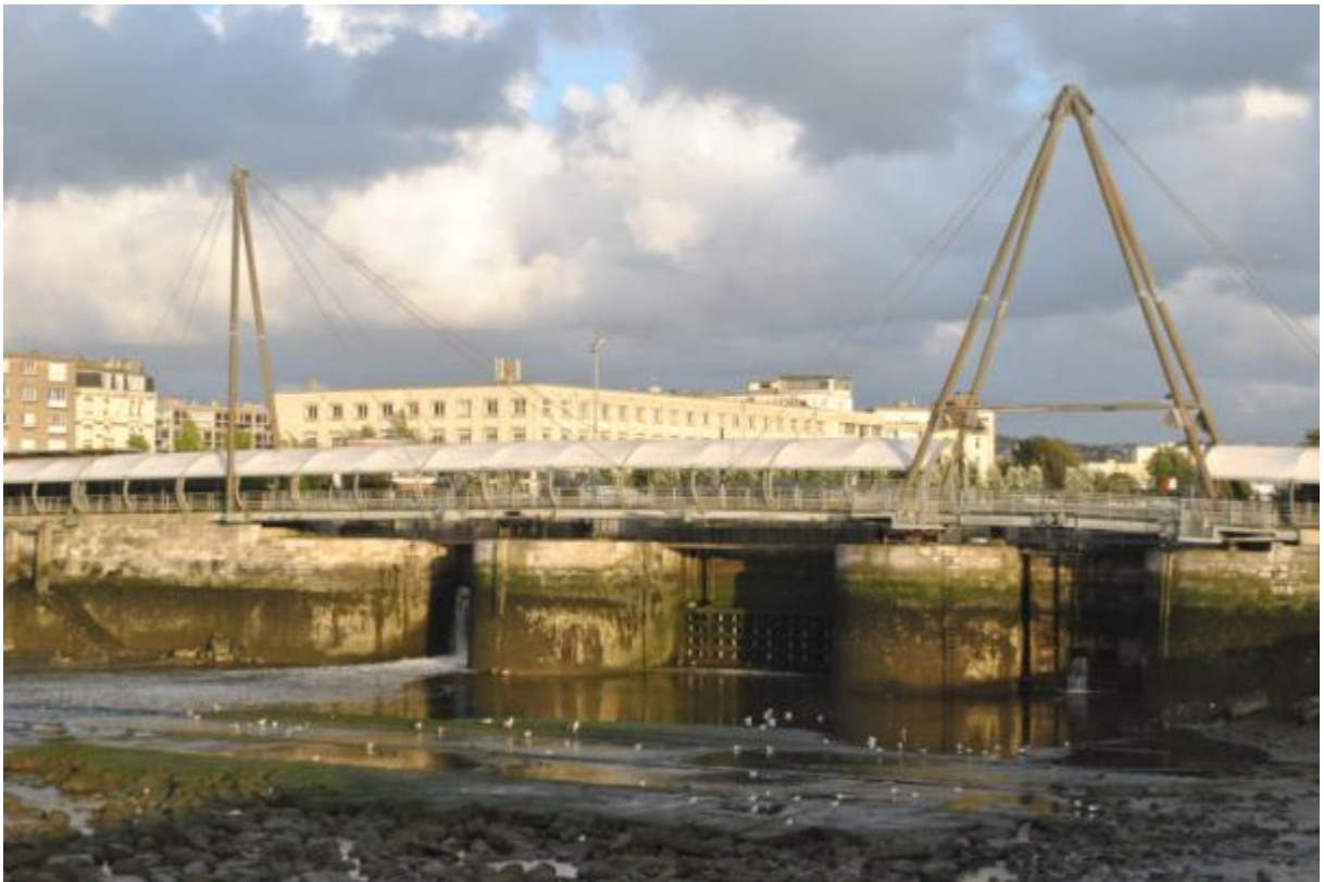
Figure 1-10. Pont-barrage Marguet à marée basse.
