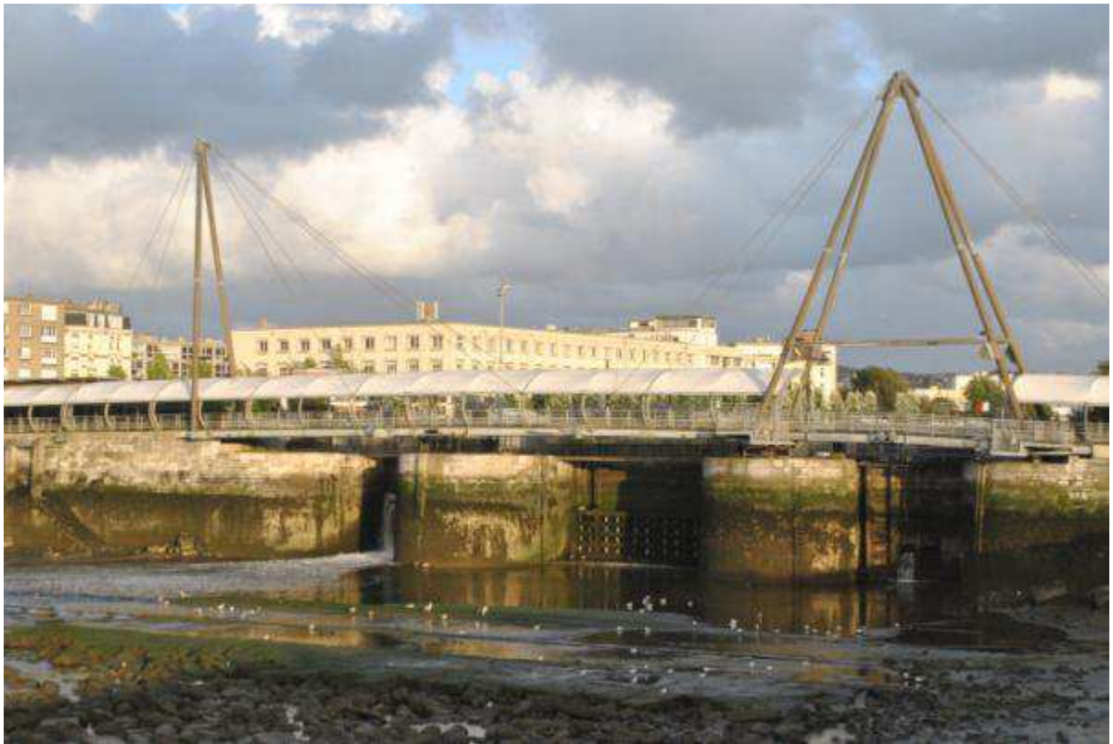
Figure 1-10. Pont-barrage Marguet à marée basse.
