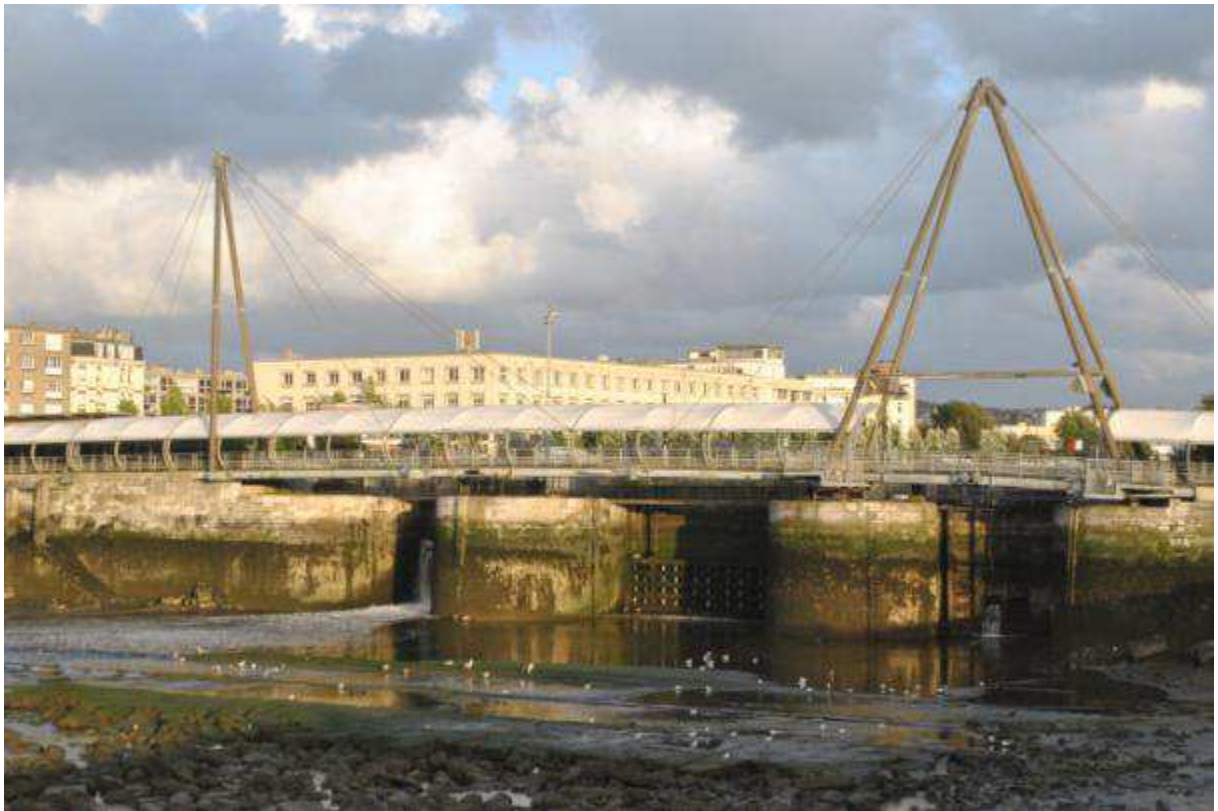
Figure 1-10. Pont-barrage Marguet à marée basse.
