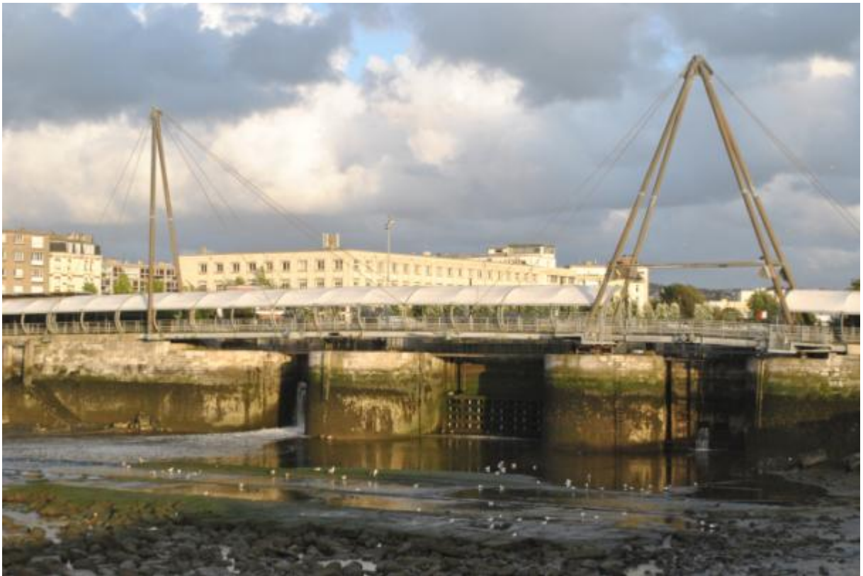
Figure 1-10. Pont-barrage Marguet à marée basse.
