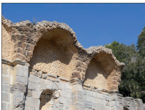
Figure A.39. Utilisation d'un tuf calcaire local dans les voûtes du Temple des Eaux de Zaghouan (Tunisie, II e s. ap. J.-C.).
