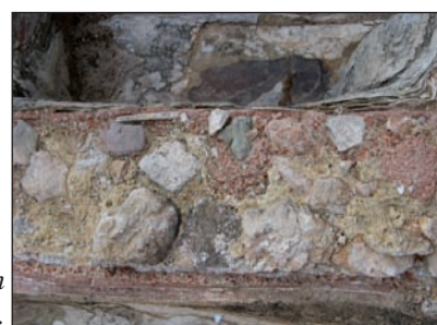
Figure B.22. Moellons en travertin dans le mur de la salle T6 des thermes.
