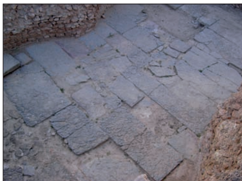
Figure B.14. Dallage en calcaire gris de Jebel Oust du sol de la salle T17 des thermes.
