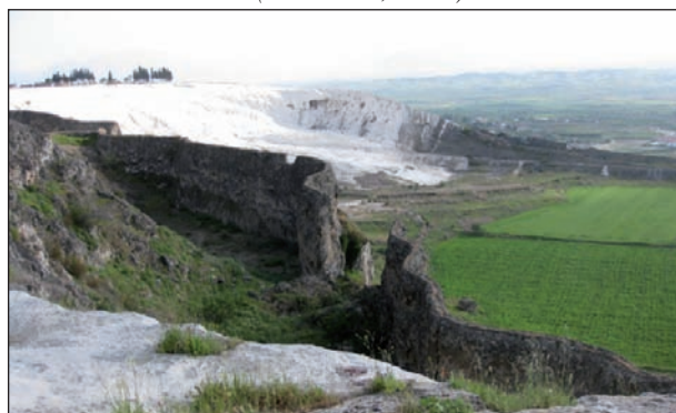
Figure A.33. Canal de travertins à Pamukkale, fracturé à la suite de séismes (Pentecost, 2005).
