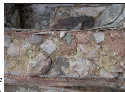
Figure B.22. Moellons en travertin dans le mur de la salle T6 des thermes.
