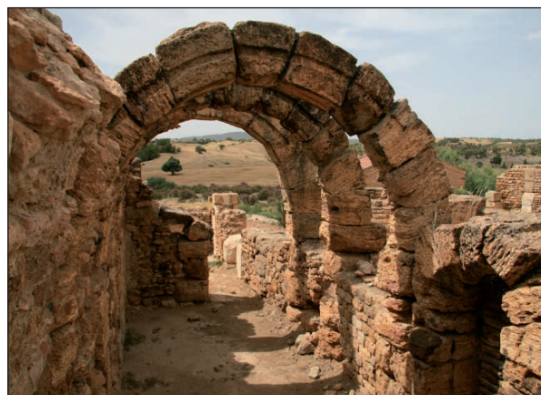
Figure A.42. Utilisation d'un travertin local dans les thermes antiques de Hammam Mellègue (Tunisie).
