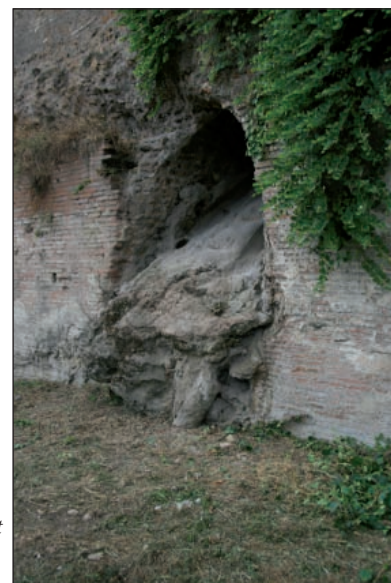
Figure A.56. Amas de dépôts carbonatés au débouché d'une canalisation alimentant des citernes joutant les thermes de Caracalla (Rome, Italie).
