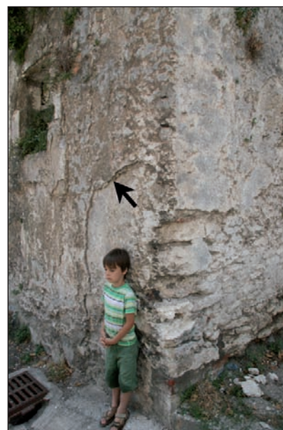
Figure A.44. Utilisation du travertin en enduit sur le mur d'une maison, village de Bagni San Filippo (Toscane, Italie).
