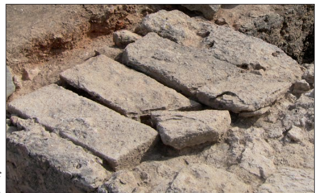
Figure B.19. Dalles de couverture en travertin de l'aqueduc thermal antique de Jebel Oust.
