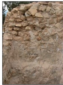
Figure B.21. Utilisation du travertin dans le mur de la salle T5I des thermes.
