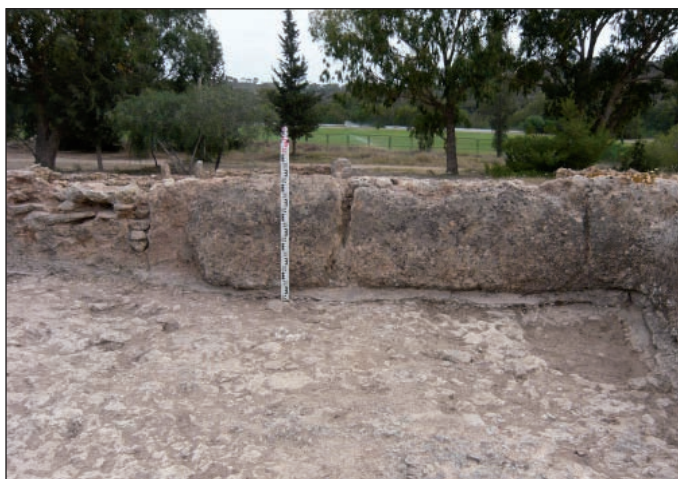
Figure B.95. Echancrures verticales dans le travertin de la salle T23 des thermes, témoignant d'une récupération du matériau et/ou d'un curage du bassin.
