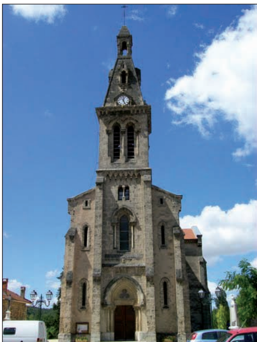
Figure A.43. Eglise de Barbieres (Drôme), construite en tuf calcaire de la région.
