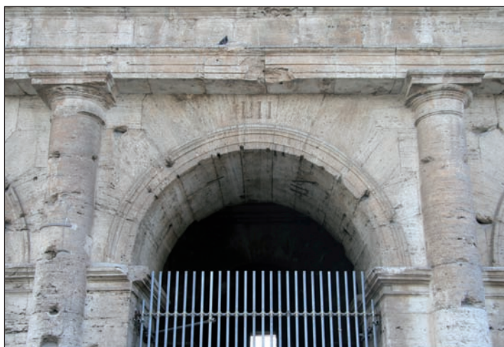
Figure A.38. Utilisation du Lapis tiburtinus dans les voûtes du Colisée à Rome (I er s. ap. J.-C.) ; notons l'effet visuel obtenu par le jeu avec la lamination naturelle du travertin.
