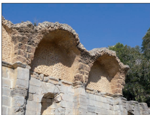
Figure A.39. Utilisation d'un tuf calcaire local dans les voûtes du Temple des Eaux de Zaghouan (Tunisie, II e s. ap. J.-C.).
