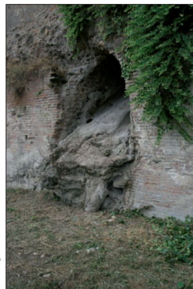
Figure A.56. Amas de dépôts carbonatés au débouché d'une canalisation alimentant des citernes jouxtant les thermes de Caracalla (Rome, Italie).
