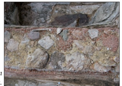
Figure B.22. Moellons en travertin dans le mur de la salle T6 des thermes.
