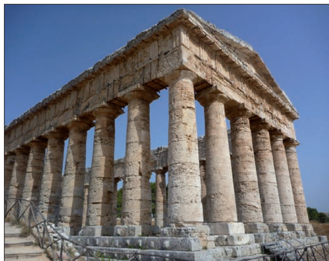
Figure A.37. Temple grec de Ségeste (Sicile, V e s. av. J.-C.), construit en tuf calcaire (« phytoherm tufa »).
