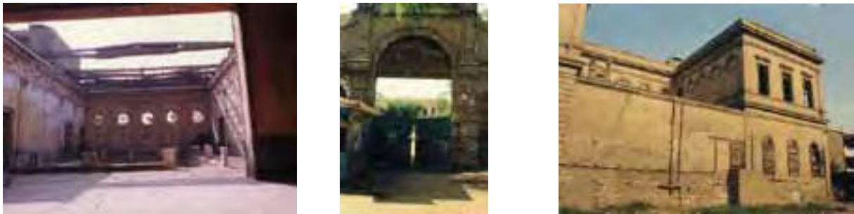
Fig. 4-57 : Le palais du prince Omar Tousson à Choubrah, maintenant dans un état détérioré et entouré par quatre écoles publiques. URL : http://www.aralg.com/vb/showthread.php?t=12565
