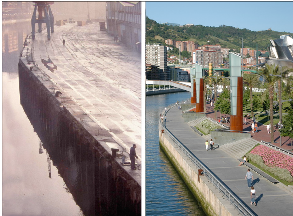
Fig. 48 – Les berges du Nervión avant et après la régénération
