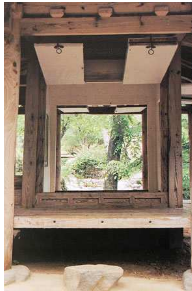
Fig. 3 : les cloisons modulables ouvertes d'une pièce dans l'architecture traditionnelle coréenne IM Sök-Jae, L'Architecture traditionnelle coréenne , op. cit., p. 57.
