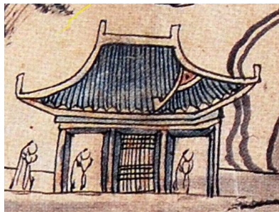
Fig. 48 : forme architecturale (détail, peinture n° 4).
