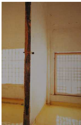
Fig. 1 : fenêtres et cloisons dans la maison traditionnelle IM Sök-Jae, L'Architecture traditionnelle, op. cit. , p. 89.
