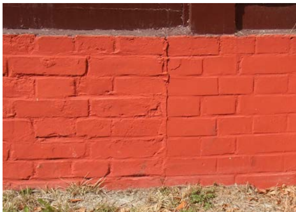
Fig.32 et 33 Soubassement de véranda rempli avec briques et peint (aujourd'hui)
