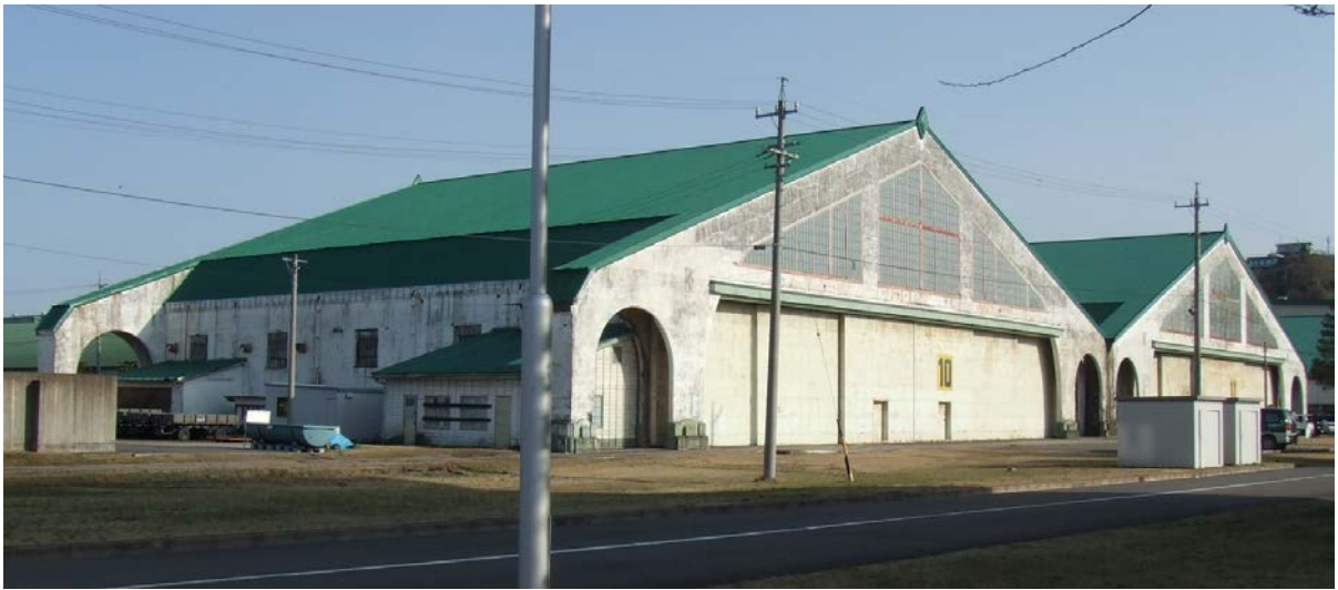
Fig.57 un hangar jumeau en béton armé à Kagamigahara
