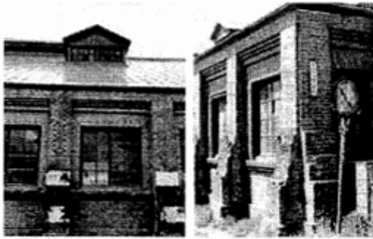
写真2 旧騎兵連隊覆馬場控壁（控柱）
