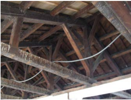
Fig.12 Structure de la ferme originale
