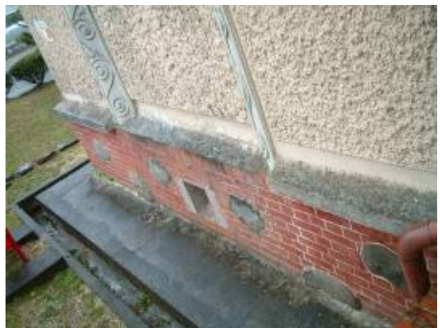
Fig.6 et 7 Les colonnes champignons sont décorées de frises, la base est montée de briques
