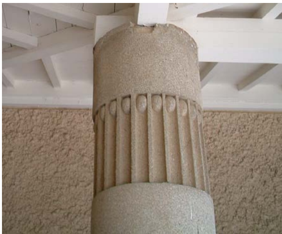
Fig.6 et 7 Les colonnes champignons sont décorées de frises, la base est montée de briques
