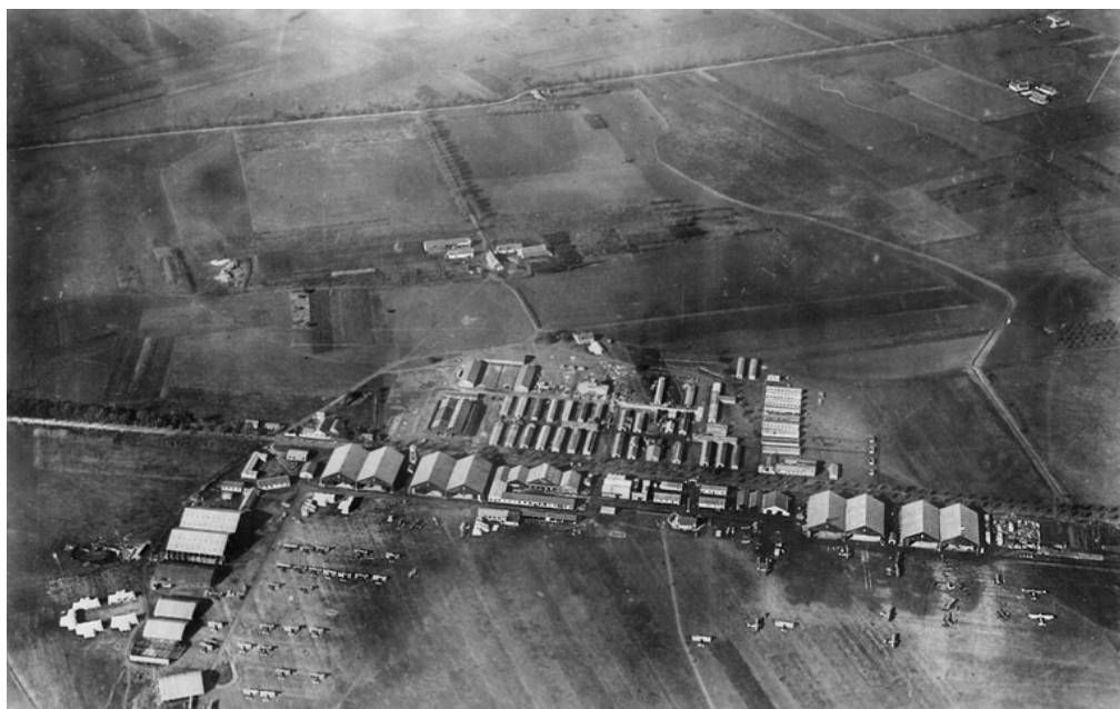
Fig.20 Photo aérienne de l'école d'aviation à Tours en 1918
