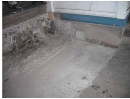
Fig.22 Aucune trace de marche originale sous les marches en béton qui ont été ajoutées plus tard
