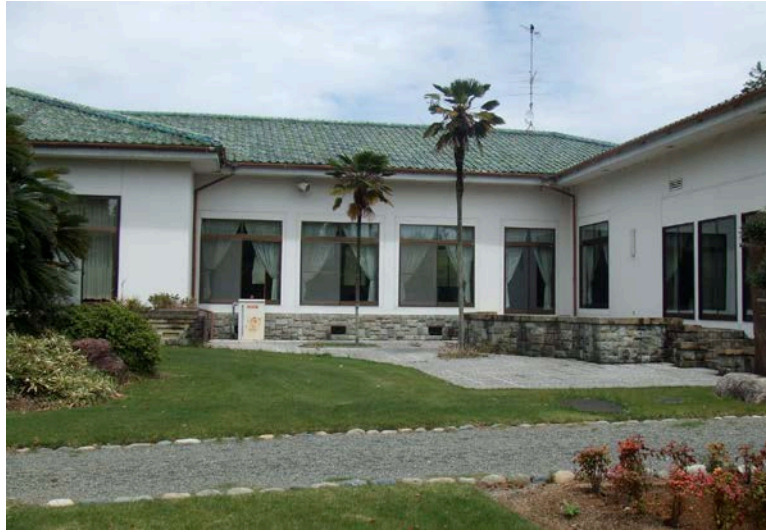
Fig.37 Ancien mess des officiers du 7 e régiment d'aviation
