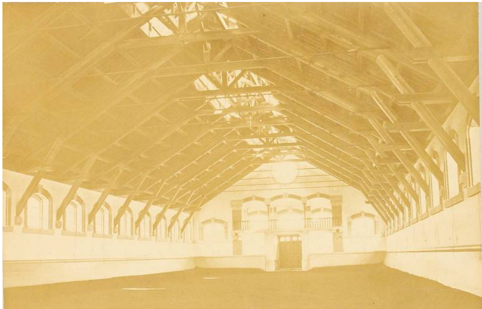
Fig.15 Photo de l'intérieur du manège prise par Kreitmann « INTERIEUR DU MANEGE DE L'ECOLE DE CAVALERIE. »
