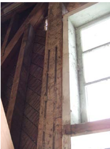
Fig.18 Crénelage des poteaux
