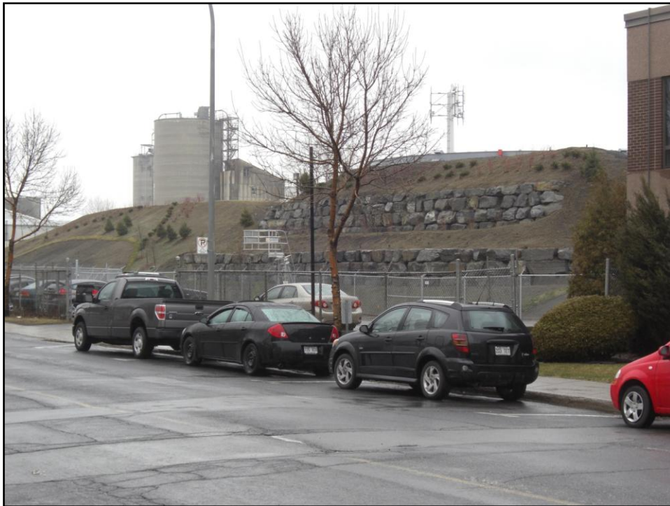
Photographie 10 - L'aménagement de talus (1)
