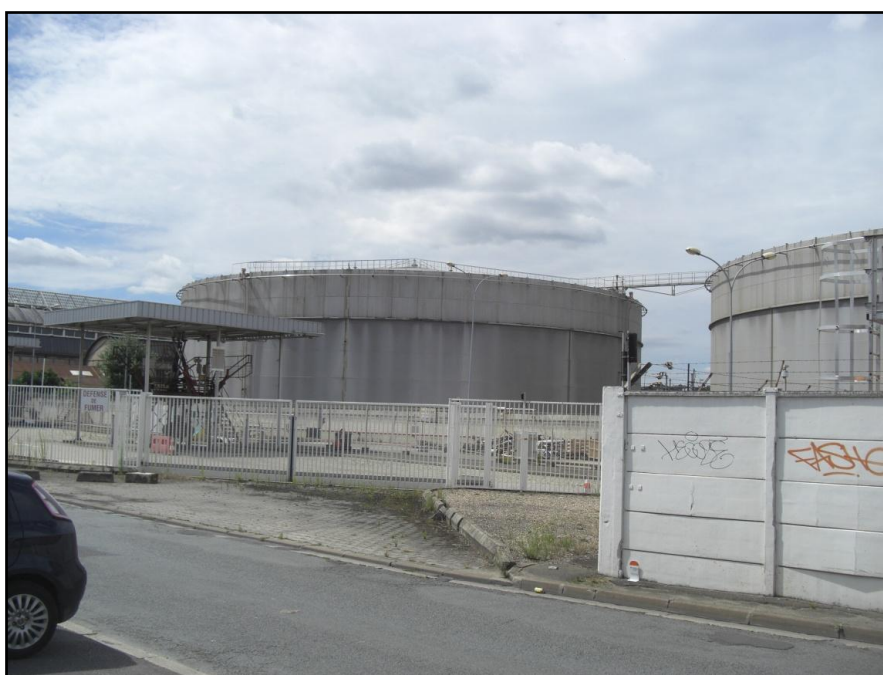
Photographie 6 - Une des cuves de stockage du dépôt Delek
