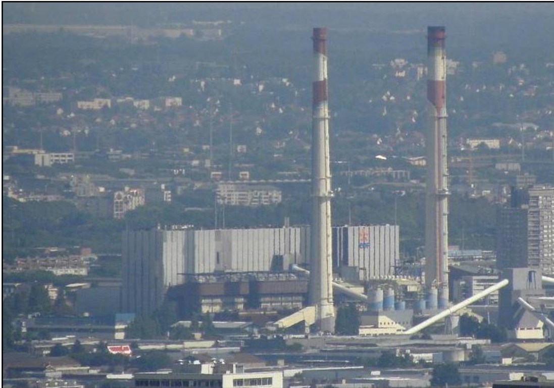
Photographie 4 - Les cheminées de la centrale thermique de Vitry-sur-Seine
