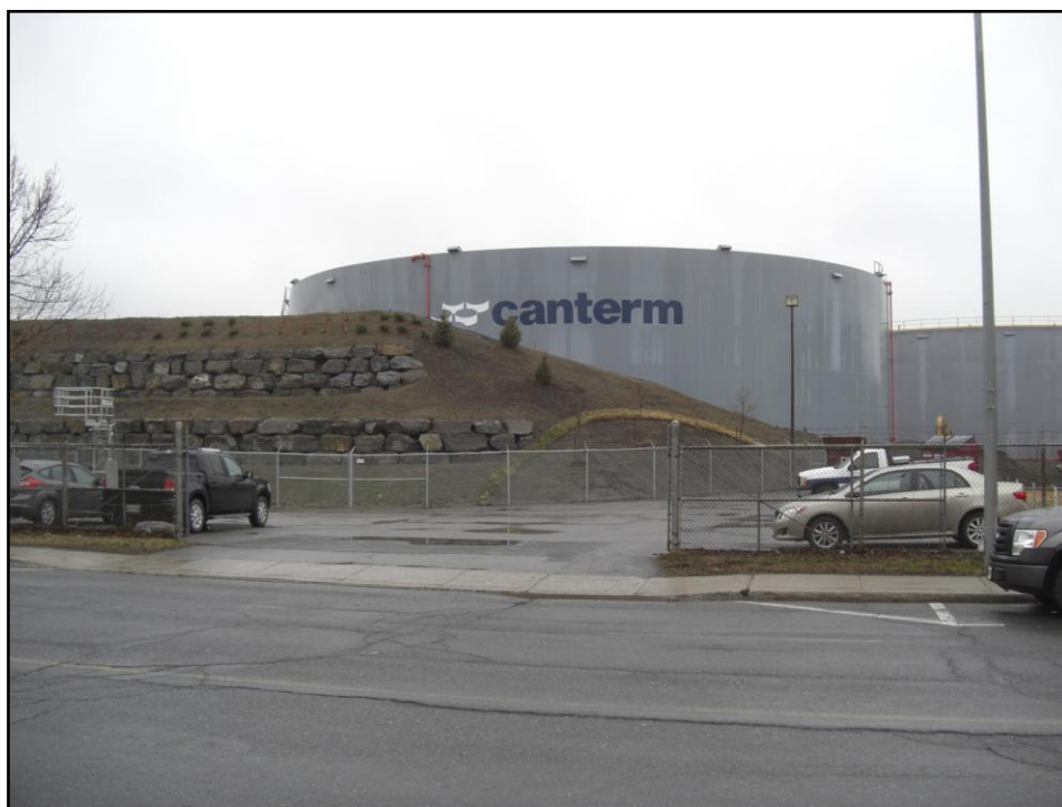
Photographie 11 - L'aménagement de talus (2)
