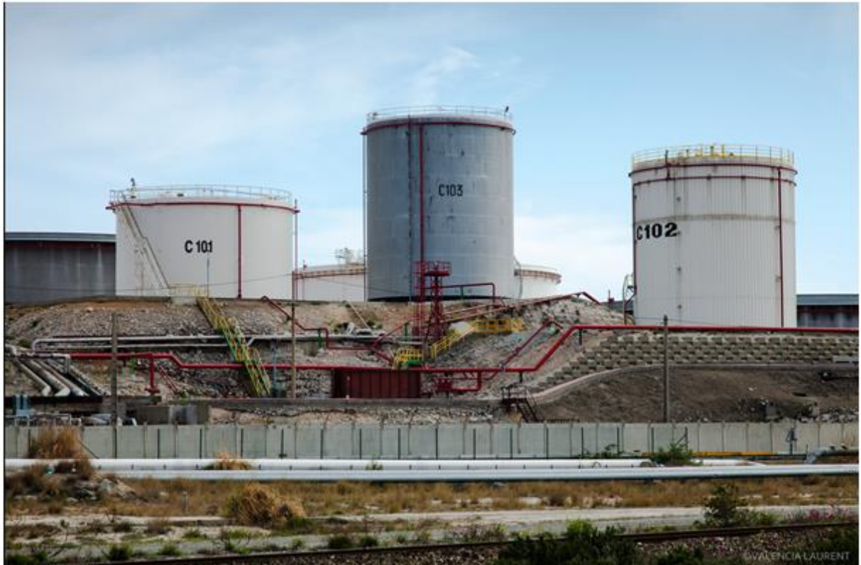
Figure I-5 : Stockages et conduites de fluides - Site de Lavéra Martigues - Photo Laurent Valencia ©
