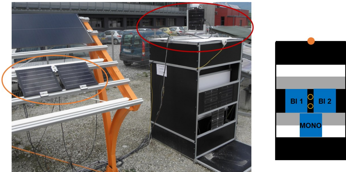
Figure 2.10 – (gauche) Photographie du banc de test entre avril 2013 et décembre 2013 destiné à l'étude de l'influence de l'architecture des modules (configuration représentée : réflecteur blanc de taille 3c \times 2c centré à une distance 0,5c derrière les modules). Configurations supplémentaires entourées sur la photographie : modules faces avant seules orientés à angle latitude en orange, et module biface vertical orienté est - ouest sur le toit du banc en rouge. (droite) Schéma montrant le positionnement des deux modules bifaces et du module monoface, ainsi que la nouvelle position des pyranomètres SP Lite (en jaune – orientés vers le réflecteur).
