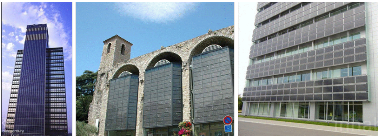
Figure 1.20 – De gauche à droite, photographies d'une façade PV classique pour l'utilisation de grandes surfaces à empreinte au sol nulle, d'une façade double peau pour la rénovation énergétique de bâtiments anciens, et de la façade PV biface du bâtiment Sanyo (reproductions issues respectivement de [98], [99] et [93]).
