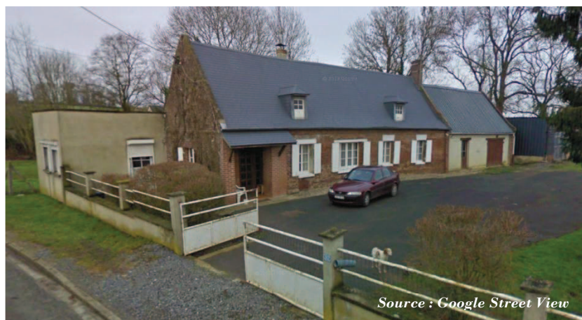
Figure 64. Profil type des habitations sinistrées en 2007 à Berlancourt
