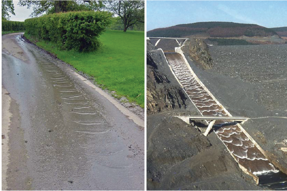
FIGURE 1.1.1 : Train d'ondes suite à un ruissellement d'eaux pluviales (à gauche) et dans un évacuateur de crue (à droite). Source : C. Ancey, Cours d'hydraulique à surface libre, p238 [4]
