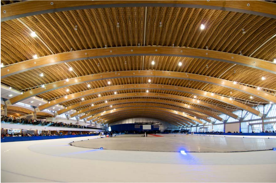
Figure 1.14 – Exemple de charpente BLC (Anneau olympique de Richmond, Canada, 2008)
