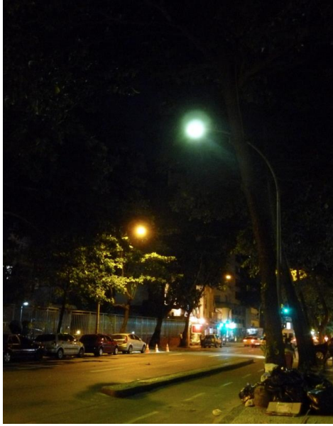
Figures 192 et 193 – Problèmes d’entretien : disparité des ampoules installées et des arbres qui font écran aux luminaires. Source : Ivone Chou (2011)
