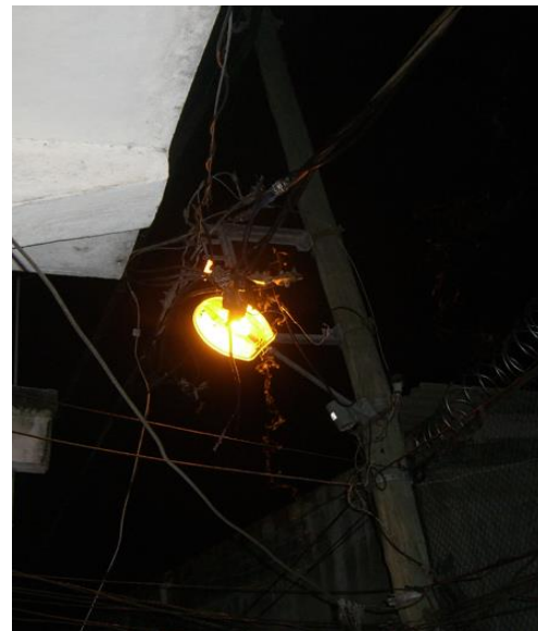
Figures 198 et 199 - Les branchements clandestins peuvent entraîner des accidents, comme incendies et courts circuits comme c'est arrivé avec le câblage à côté de ce luminaire à Pavão-Pavãozinho. Source : Márcia Souza (2010).
