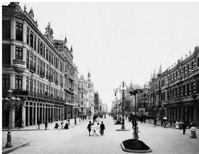
Figure 10 : L'éclairage mixte de l'avenue Centrale, l'éclairage électrique au centre et à côté l'éclairage à gaz, 07/10/1906. Augusto Malta Source : KOK (2005).
