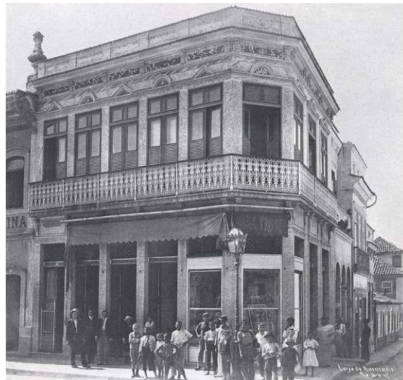
Figure 07: Bec de gaz au Largo da Misericórdia (centre-ville), Augusto Malta (1907). Source: MENDONÇA (2004).
